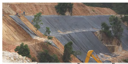
การวางแผน Geotextile ป้องกันการชะล้าง พังทลายบริเวณที่เก็บกอง
